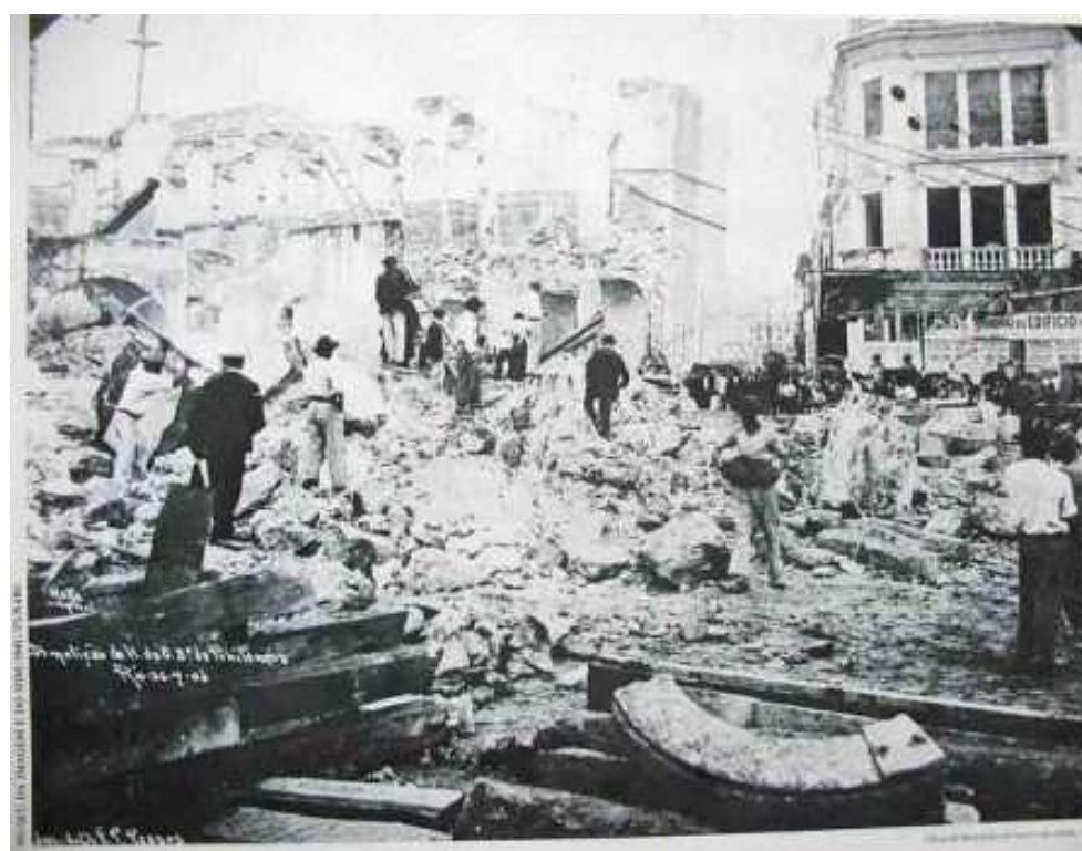
Figura 3. Demolições para as obras de Pereira Passos. Fonte: CATRACA LIVRE, 2013.
